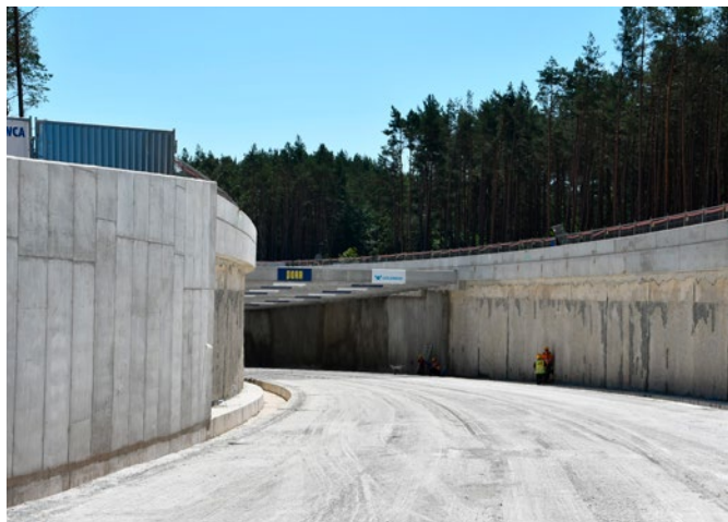
Prace prowadzone są nie tylko na odcinku drążonego tunelu. Przebudowywane i budowane są sieci uzbrojenia terenu i infrastruktury drogowej oraz prowadzone prace drogowe
