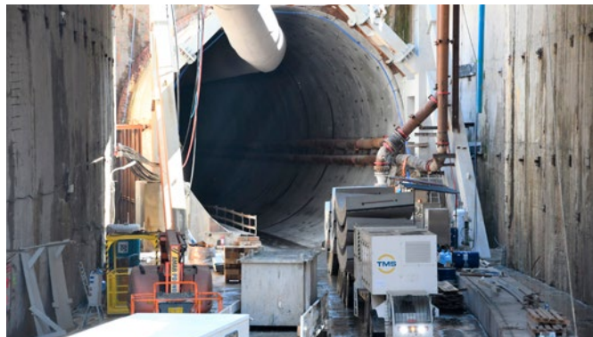
Po wydrążeniu tunelu wykonana zostanie płyta, na której będzie zlokalizowana jezdnia, a pod nią galeria ewakuacyjna.
