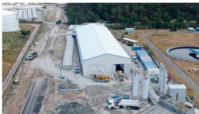
Do obudowania tunelu przygotowano 615 dwumetrowych i 170 półtorametrowych pierścieni
