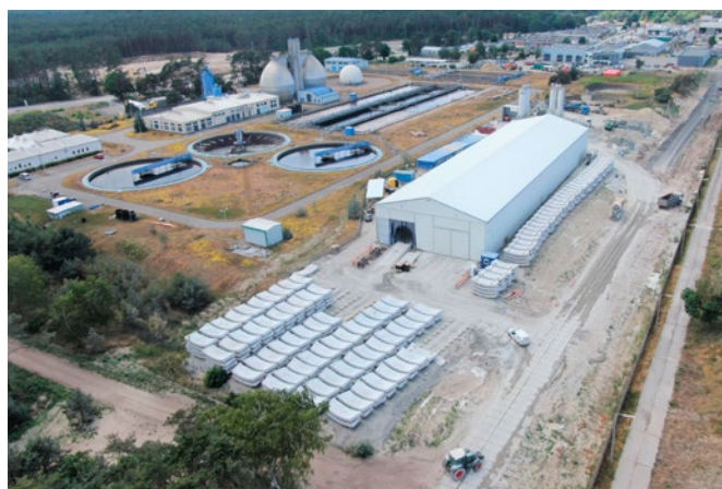
Do połowy sierpnia „Wyspiarka” ułożyła 170 ringów półtorametrowych oraz 393 dwumetrowe
