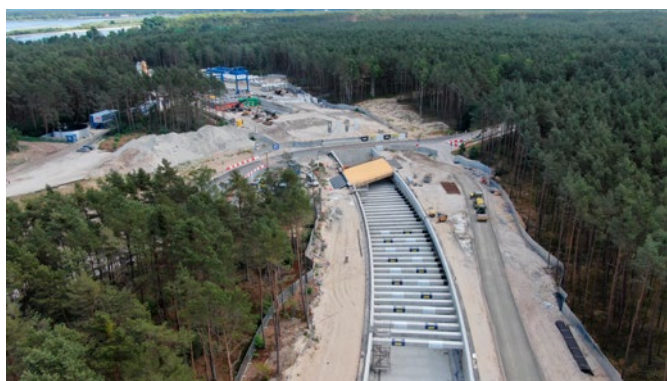
Tak będzie wyglądał wjazd do tunelu od strony wyspy Uznam
