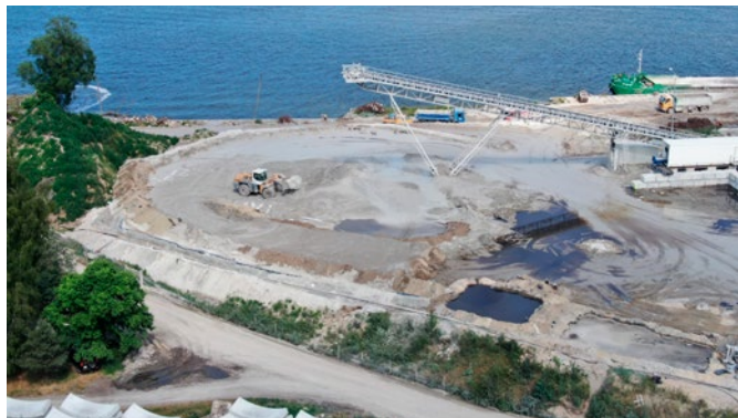
Na wyspie Uznam trwają także przygotowania do budowy centrum obsługi i budynku Trafo K3
